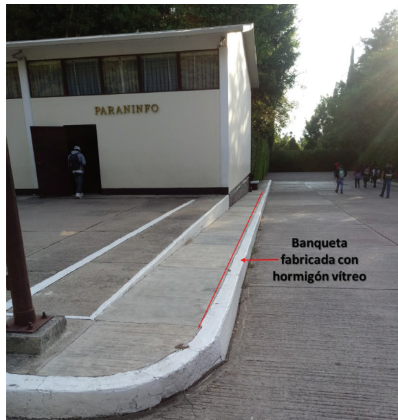
Figura 12. Banqueta lateral del Paraninfo de la UTM elaborada sustituyendo el 100% de la arena por vidrio de desecho proveniente de los tubos de rayos catódicos.
